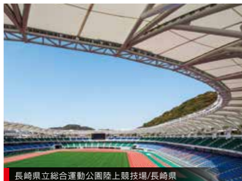
長崎県立総合運動公園陸上競技場/長崎県
