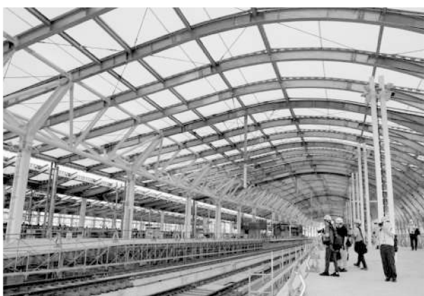
今秋開業予定の西九州新幹線・長崎駅（長崎市）。中興化成工業の膜材が採用された。新幹線駅として唯一の膜屋根で、夜間は下側からのライトアップで照らされる見込み
